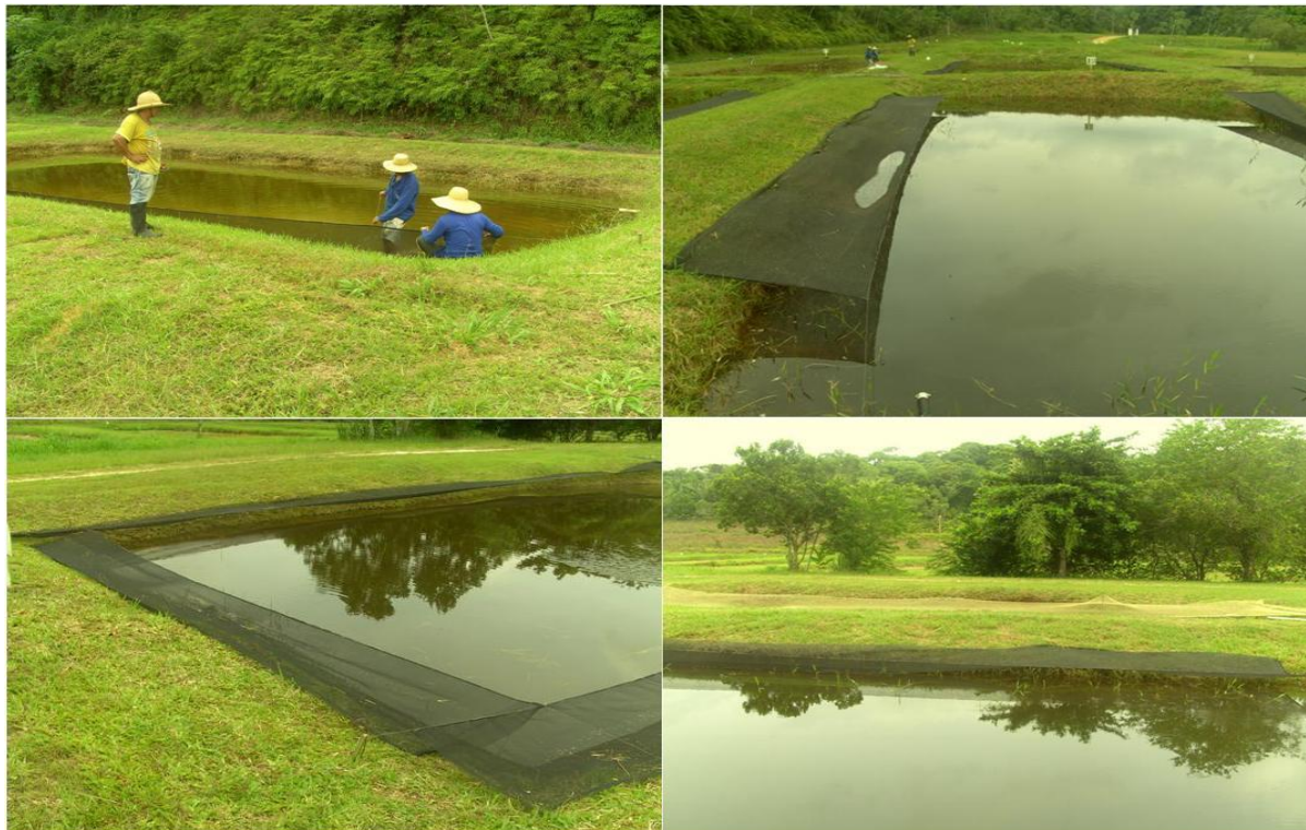
Figura 4: Colocação de uma tela sombrite com 50 cm de largura costurada em um fio de arame fixo nas laterais do viveiro.
