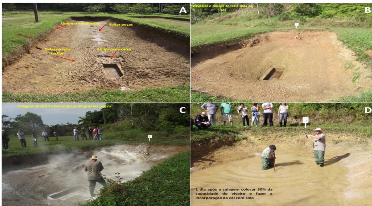
Figura 2: A) Drenagem total do viveiro, mas ainda com pequenas poças de água; B) viveiro totalmente limpo e seco; C) Calagem; D) Incorporação do calcário.
